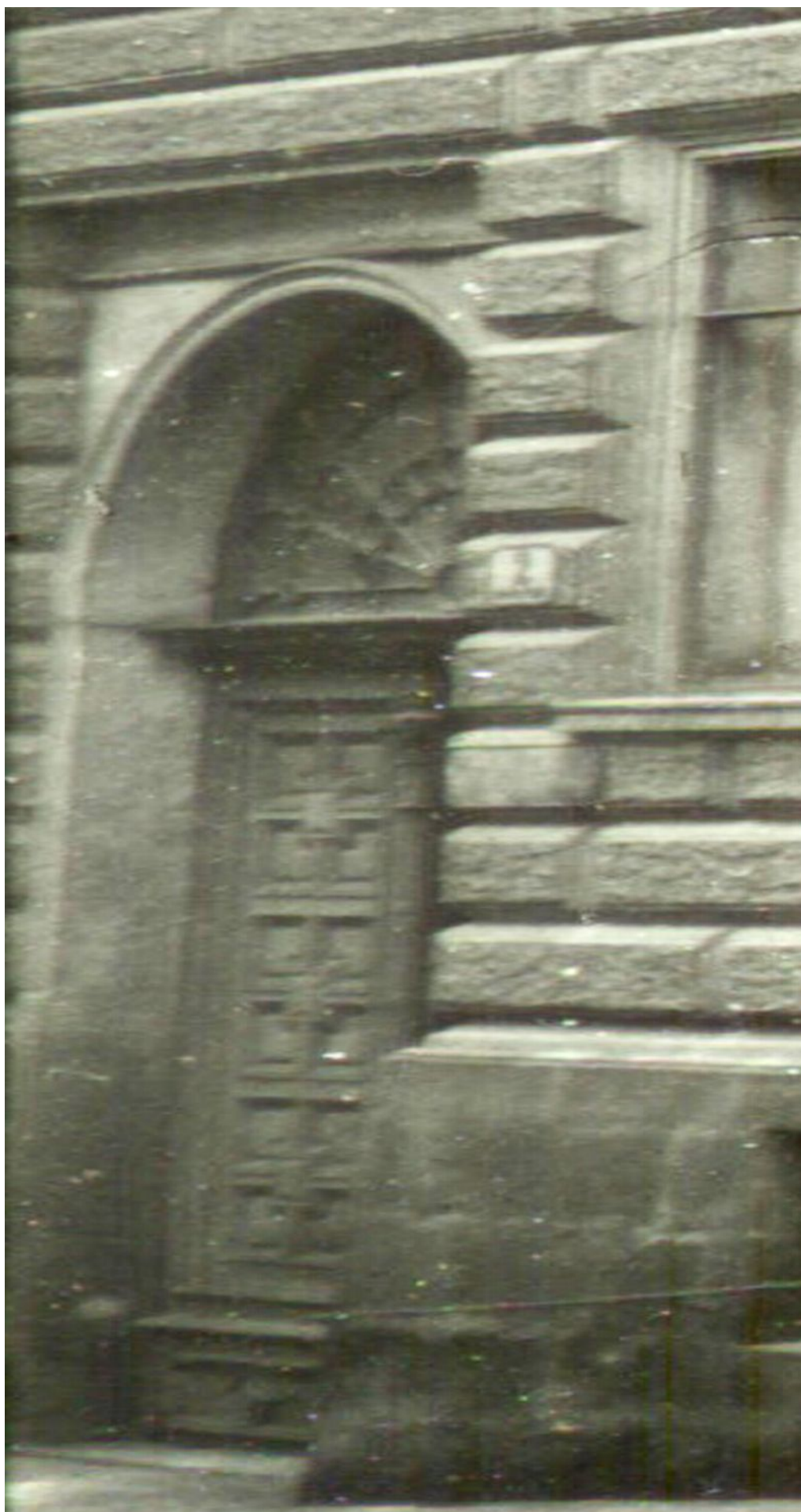
Budova ZUŠ, Školní ul. 13 - obnova oken současná podoba a doložený historický vzhled
