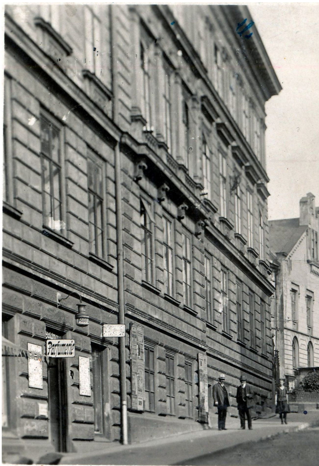
Budova ZUŠ, Školní ul. 13 - obnova oken současná podoba a doložený historický vzhled
