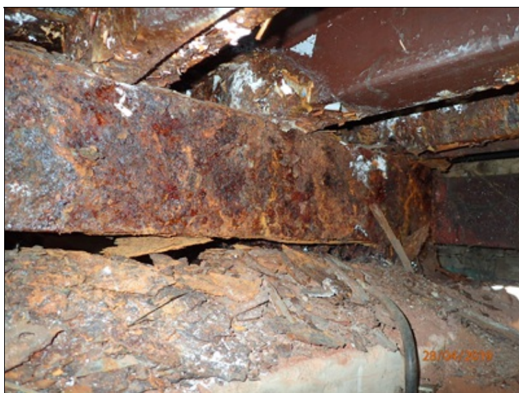
Podhled mostovky nad O3, podporový příčník + levé posuvné ložisko.
