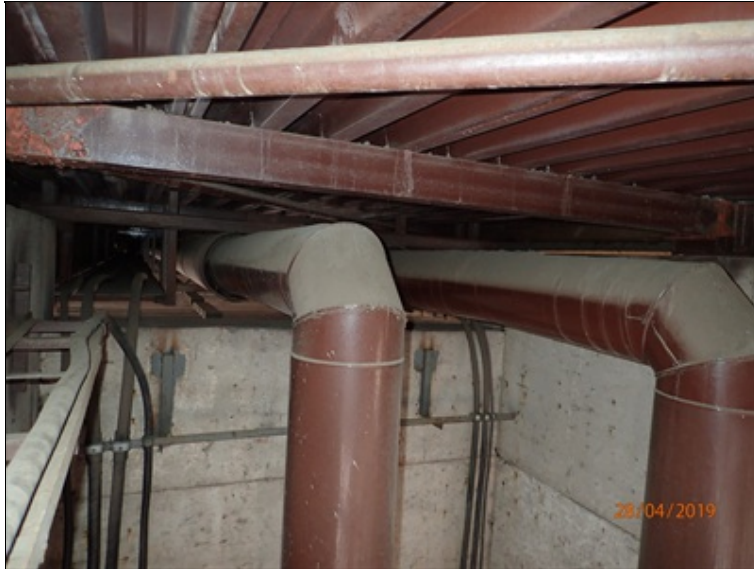
Pilíř P2, vrchol řachty, pohled do technologického prostoru řměrem do pole 1.
