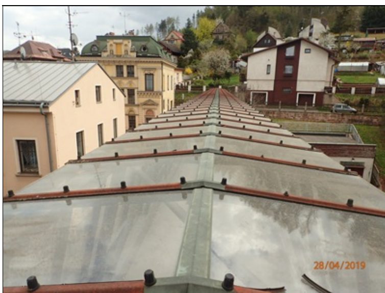
Pohled na prosklené zastřešení z portálu nad opěrou O1.
