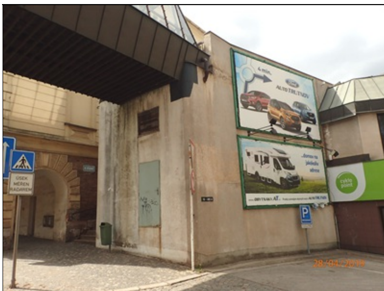
Opěra O1, čelní stěna + levý bok.
