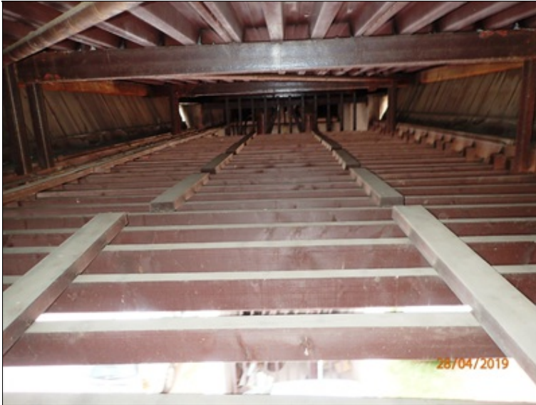
Podhled mostovky, pole 2, technologický prostor ze střechy energocentra směrem k pilíři P2.
