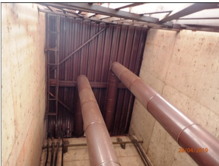
Pilíř P2, pohled vzhůru technologickou šachtou k mostovce.
