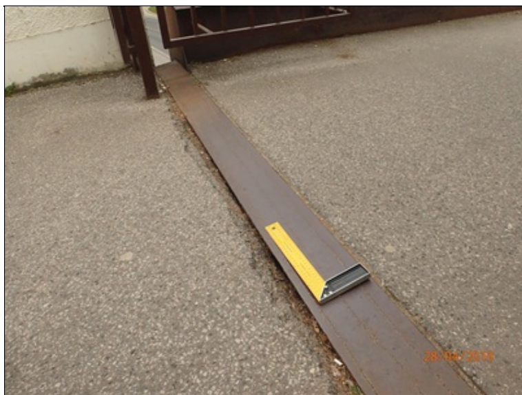
Pohled v linii mostního závěru nad O1.
