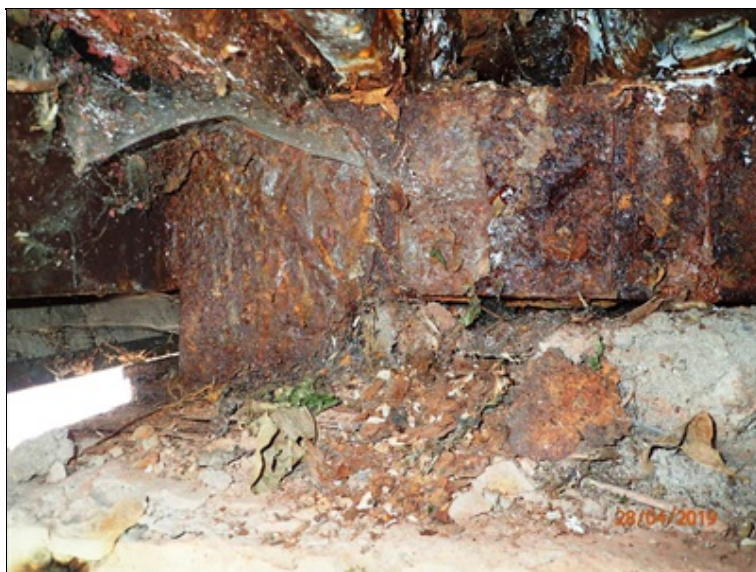
Podhled mostovky nad O3, pravé posuvné ložisko.
