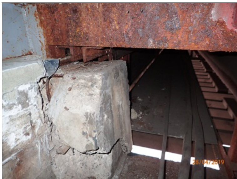
Komora O1, rozlomený vrchol stěny pod levým ložiskem.
