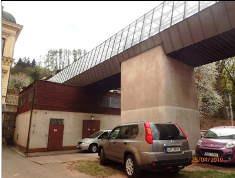
Levý bok, budova "energocentra", pilíř P2, pole 2.
