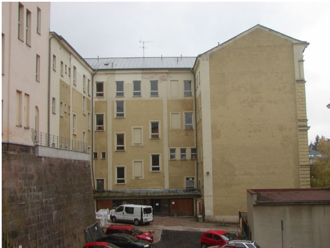
Budova Školní 13 v Trutnově - výměna oken 2. etapa - dvorní část
