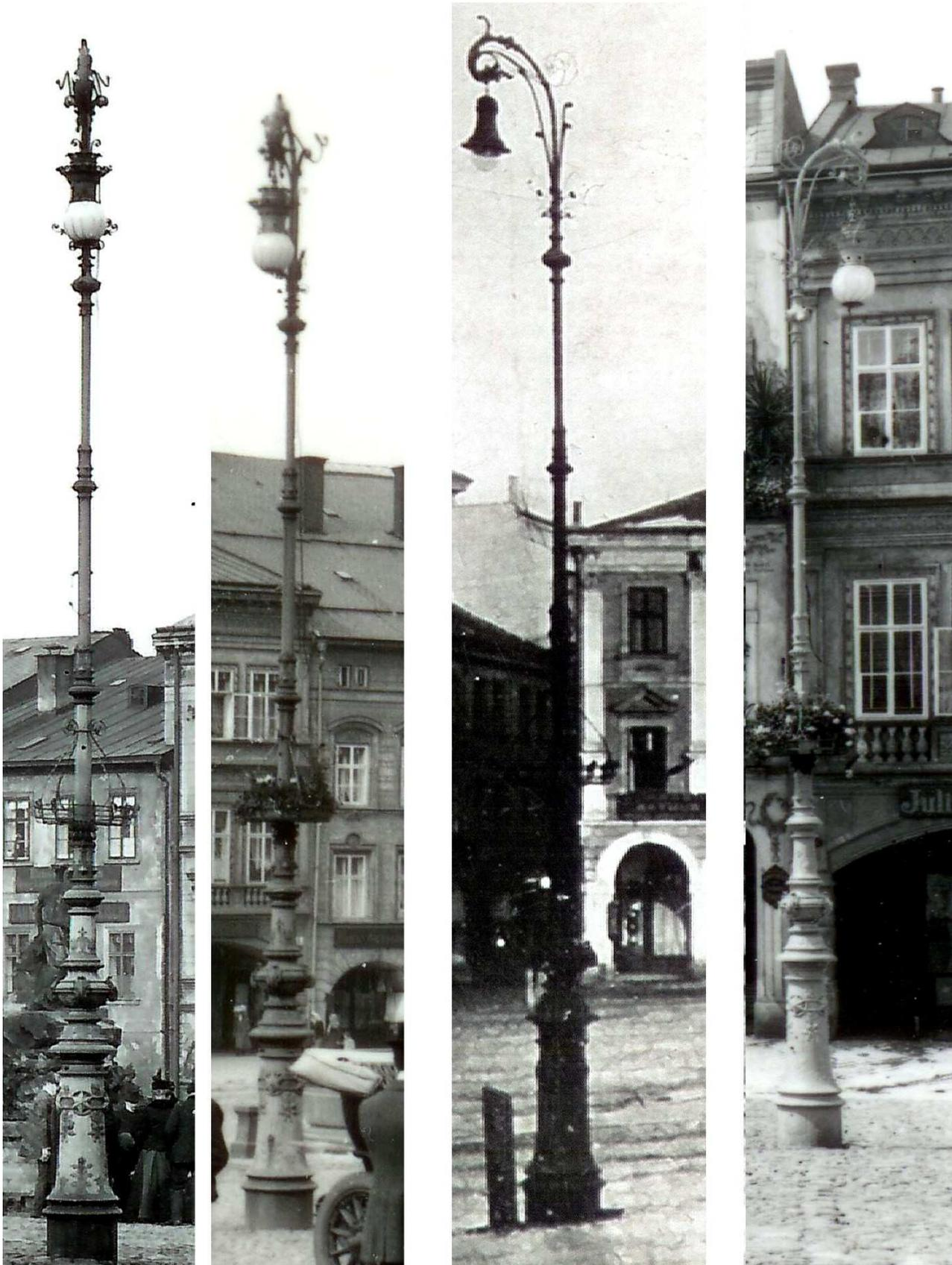
Ausschnitte von Fotos mit Details der Beleuchtungsmaste am Platz Krakonošovo náměstí in Trutnov aus der Zeit 1900 - 1940, im Laufe der Zeit wurden die Leuchtkörper für modernere ausgewechselt, der Mast mit dem Ausleger blieb der ursprüngliche.
